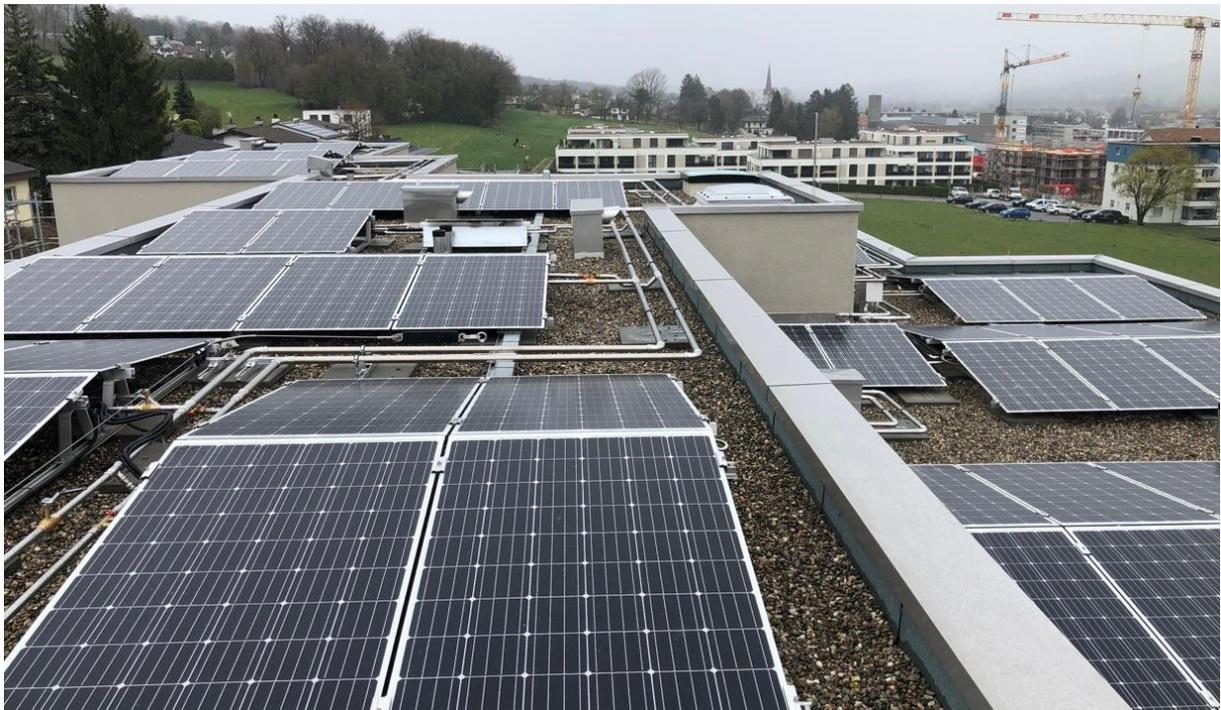
Mit der Thermischen Energie wird der Eisspeicher regeneriert und die Quellentemperatur der Wärmepumpe erhöht. So erreicht diese eine sehr hohe, d.h. effiziente Systemjahresarbeitszahl von über 4.3. Etwas mehr als die Hälfte der Stromproduktion deckt den Strombedarf der Wärmepumpe für die Heizung und Warmwasseraufbereitung. Die andere Hälfte steht den Bewohnern als Solar-Strom zur Verfügung.
