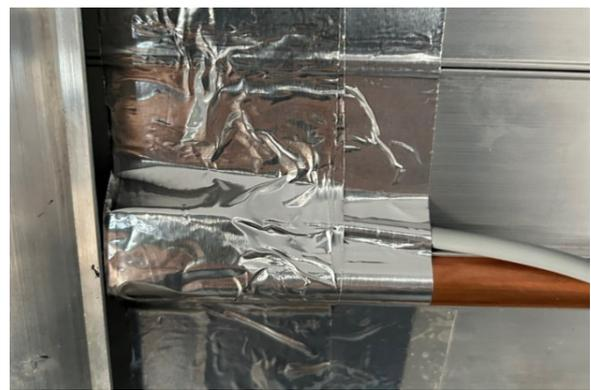
Das Kompriband kann so den Fühler gegen die Modulrückseite pressen und sorgt für eine thermische Trennung vom Modulrahmen und für eine mechanische Sicherung unter dem Klemmprofil.
