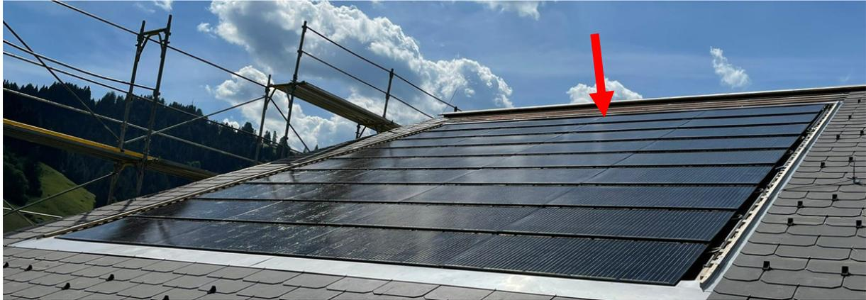
Die BlackDiamond-Hybridkollektoren BSM-425/FSH-450 werden hydraulisch immer parallel angeschlossen. Hier ist ein Kollektor auszuwählen, der sich von der Verrohrungsdistanz zum Hauptrücklauf im näheren Drittel befindet. Also nie der dem Hauptrücklauf am nächsten oder weitesten weg liegende Kollektor.
