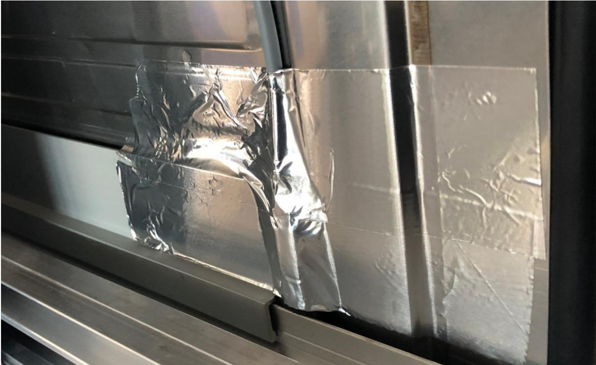
Das Kompriband kann so leichten Pressdruck ausüben und den Fühler an die Kollektorrückseite pressen. Auch wirkt es isolierend gegenüber der Umgebungs- und Unterkonstruktionstemperatur.
